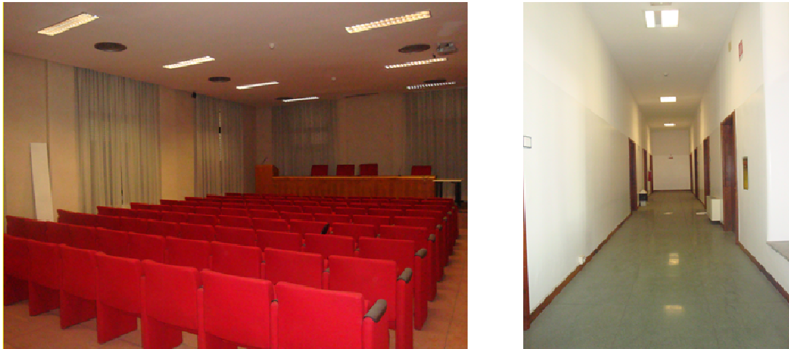
Figura 8 – Stato di fatto dei controsoffitti
