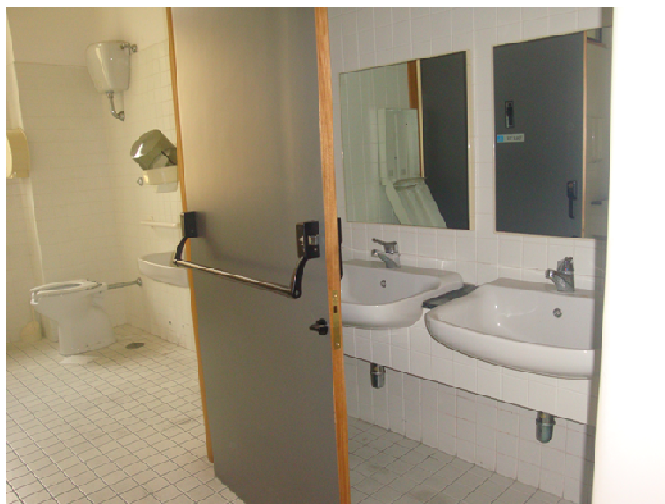
Figura 7 – Pavimento in ceramica servizio igienico
