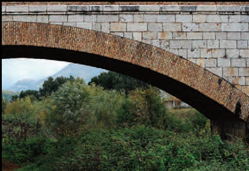
Ponte sul fiume Amaseno
