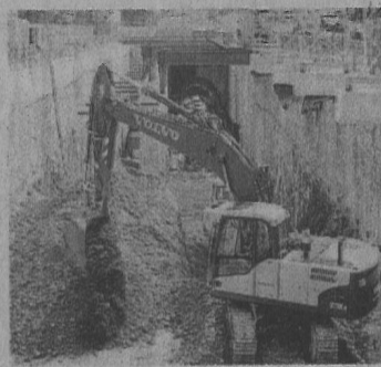
TERRE DI SCAVO
