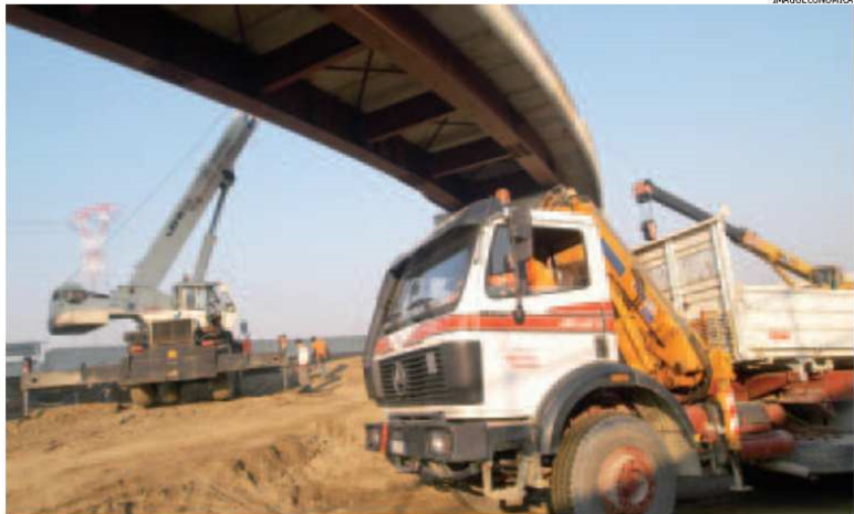
Lavori per la Tav. Un cantiere dell'alta velocità ferroviaria
