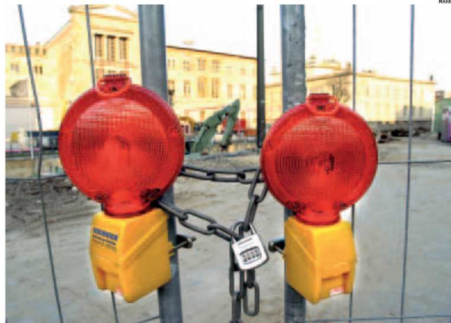
Lavori bloccati. La paralisi dei cantieri, grandi e piccoli, causa una forte perdita di competitività per le imprese
